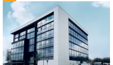
9 Cluster Photonik (1. Bauabschnitt)
